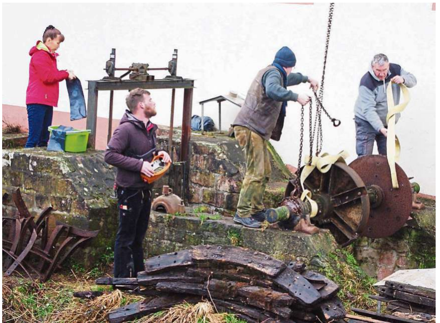
Anpacken hieß es für Freiwillige des Vereins Erbacher Plattform zwischen Mümlinginsel und Schlossmühle: Dort musste das marode gewordene Mühlenrad demontiert werden, um einem neuen Platz zu machen. Die Wiederherstellung einer funktionierenden und ansprechenden Konstruktion ist das erste Projekt der jungen Bürgergruppe zur Verbesserung der Innenstadt. Fotos: Hans-Dieter Schmidt
